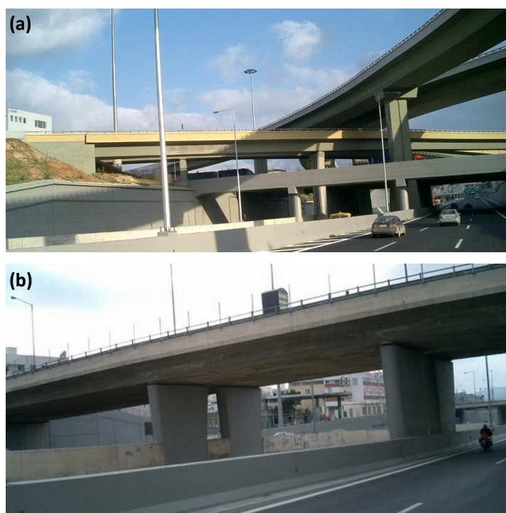
Σχήμα 6: Περιπτώσεις (α) κόμβων και (β) άνω διαβάσεων της Αττικής Οδού
