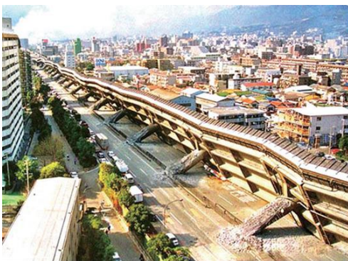
Σχήμα 14: Γέφυρα Fukae (Hanshin Expressway Route 3) μετά το σεισμό του Kobe 1995, γεωμετρικά χαρακτηριστικά βάρου γέφυρας.
