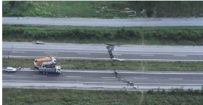
Σχήμα 3.1.2: Θραύση οδοστρώματος λόγω μετάθεσης ρήγματος, σεισμός Kocaeli, 1999.
