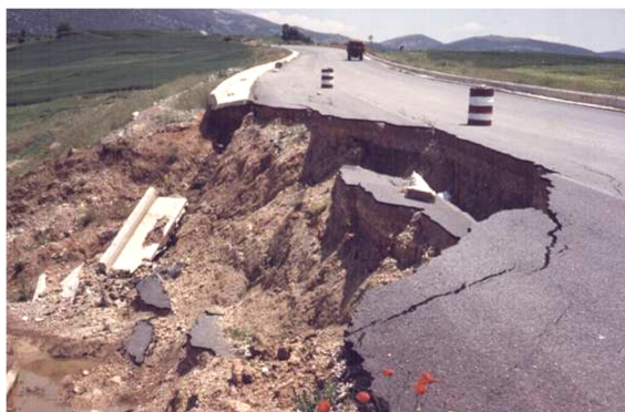
Θραύση οδοστρώματος, σεισμός Λευκάδας, 2003
