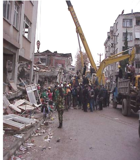
Εργασίες κατεδάφισης κτιρίου, σεισμός Duzce 1999.
