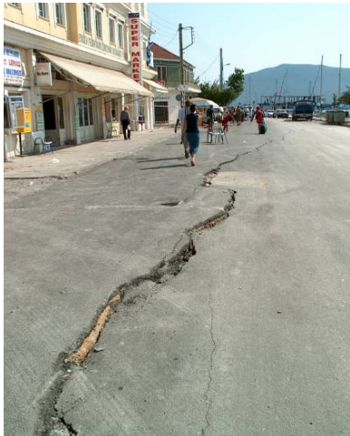
Θραύση οδοστρώματος, σεισμός Λευκάδας, 2003
