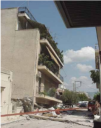
Κίνδυνος ολικής κατάρρευσης, σεισμός Πάρνηθας 1999.
