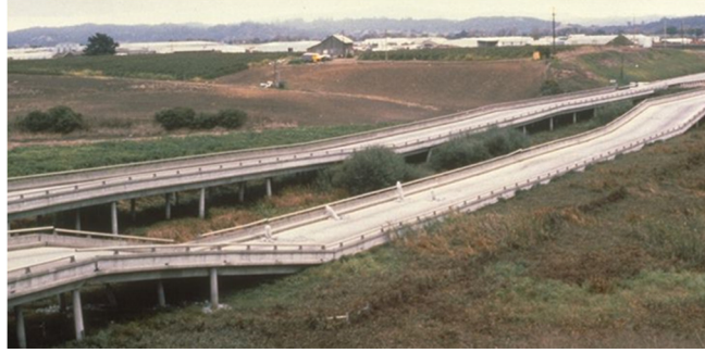
Σχήμα 3.1.1: Κλείσιμο οδού λόγω κατάρρευσης γέφυρας, σεισμός Loma Prieta, 1989.
