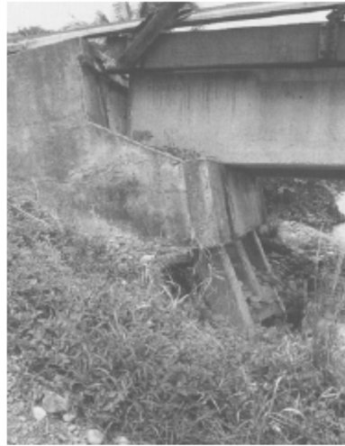
Στροφή και μετατόπιση ακροβάθρου, γέφυρα Rio Banano, σεισμός Costa Rica (1990).
