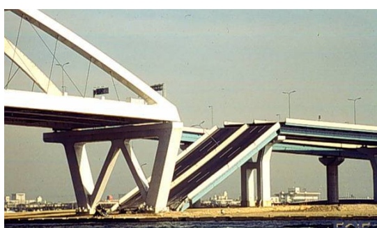
Αστοχία λόγω ρευστοποίησης. Γέφυρα Nishihomiya, σεισμός Kobe (1995).
