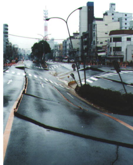
Καθίζηση οδού λόγω αστοχίας υποκείμενης κατασκευής μετρό, σεισμός Kobe, 1995.
