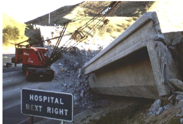
Σχήμα 3.1.9: Κατάρρευση γέφυρας κατά το σεισμό του San Fernando 1971 (ΗΠΑ) με αποτέλεσμα την παρεμπόδιση της πρόσβασης σε κοντινό νοσοκομείο.
