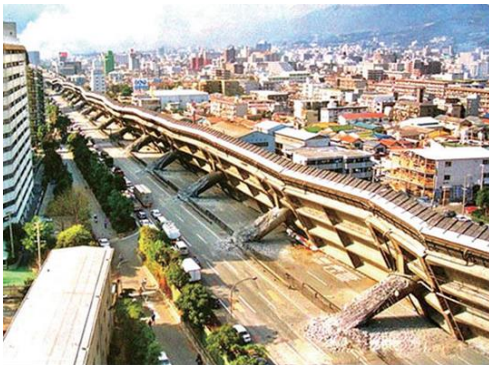
Σχήμα 2.2.6. Γέφυρα Fukae (Hanshin Expressway Route 3) μετά το σεισμό του Kobe 1995, γεωμετρικά χαρακτηριστικά βάρου γέφυρας.
