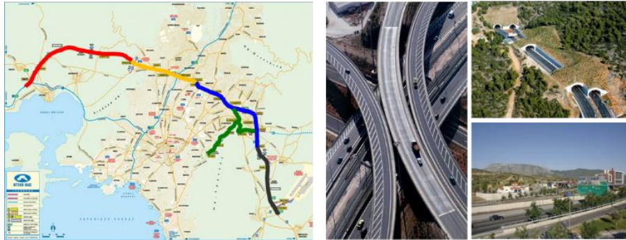
Σχήμα 2.2.2. Σχηματική απεικόνιση της Αττικής Οδού και φωτογραφίες από κάποιες ενδεικτικές κρίσιμες κατασκευές (γέφυρες, σήραγγες, κτίρια και εγκαταστάσεις) που συναντώνται κατά μήκος του δικτύου.
