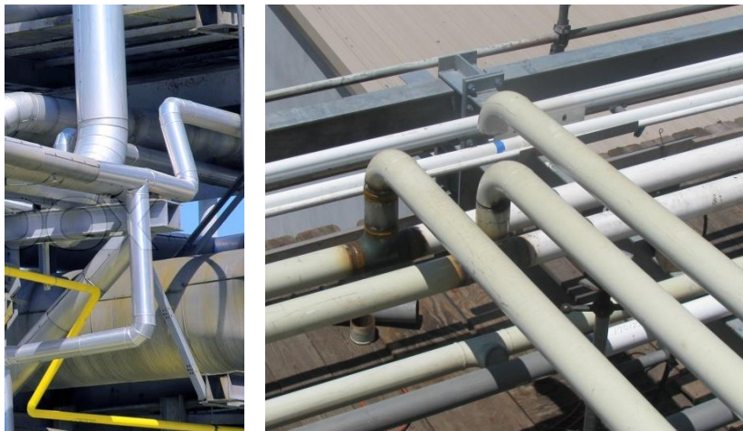
Σχήμα 11: Σωληνώσεις με συνδέσμους διακλάδωσης μορφής Ταυ.
