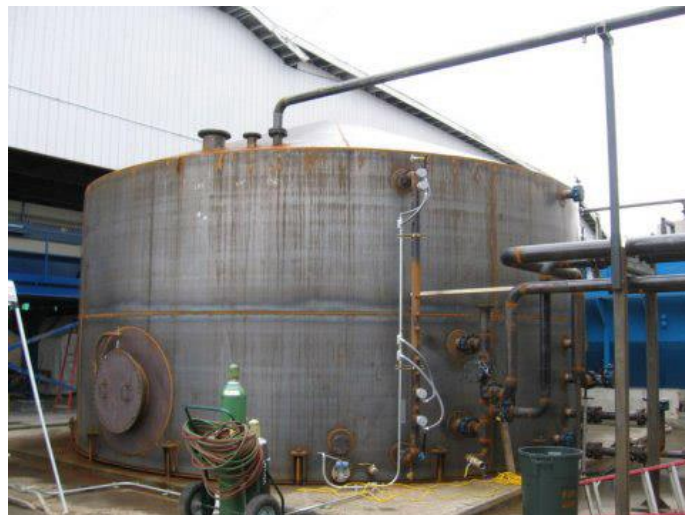
Σχήμα 16: Ακροφύσια δεξαμενής αποθήκευσης υγρών.
