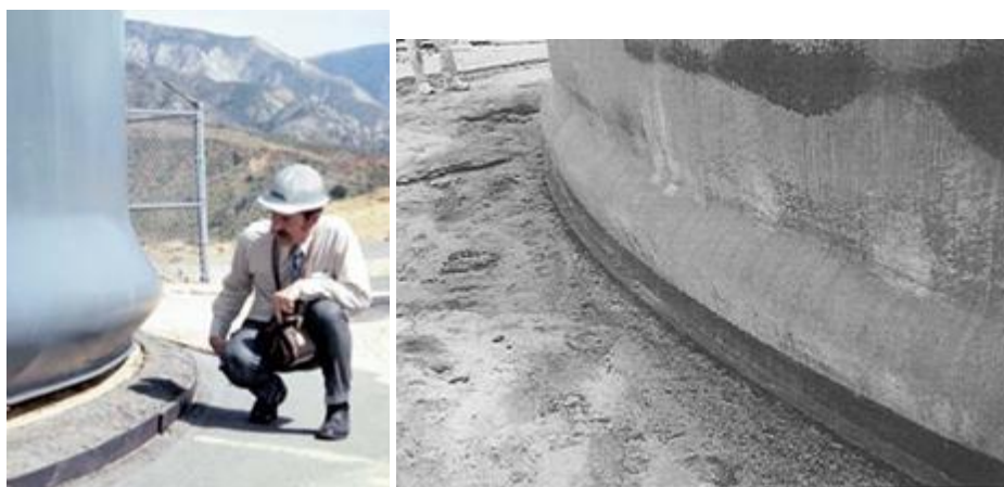
Σχήμα 32: Λυγισμός μορφής «Elephant's foot».
