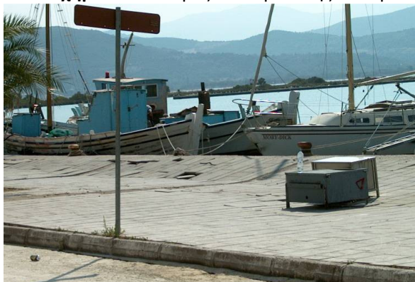
Σχήμα 2.10. Βλάβες στο λιμάνι της Λευκάδας και στην περιοχή της Μαρίνας κατά την διάρκεια του σεισμού του 2003.
