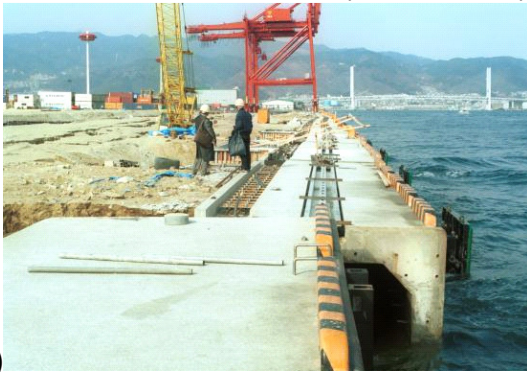
Σχήμα 2.17. (α) Μετακίνηση προς την θάλασσα και (β) κλίση κρηπιδότοιχων και εκτεταμένες καθιζήσεις επιχωμάτων κατά την διάρκεια του σεισμού του Hyogo-ken Nanbu (Kobe) το 1995.
