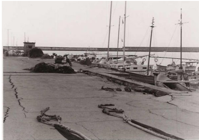
Σχήμα 2.9. Βλάβες στο λιμάνι της Καλαμάτας κατά την διάρκεια του σεισμού του 1986.
