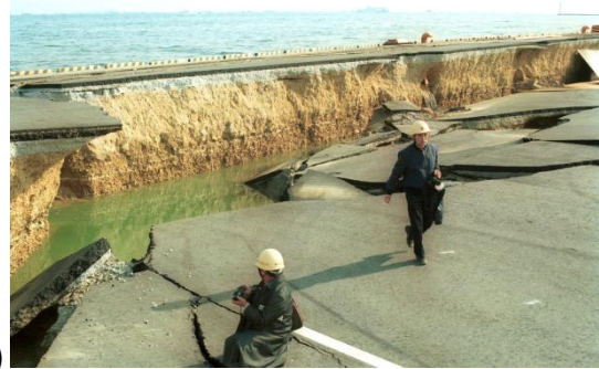
Σχήμα 2.17. (α) Μετακίνηση προς την θάλασσα και (β) κλίση κρηπιδότοιχων και εκτεταμένες καθιζήσεις επιχωμάτων κατά την διάρκεια του σεισμού του Hyogo-ken Nanbu (Kobe) το 1995.
