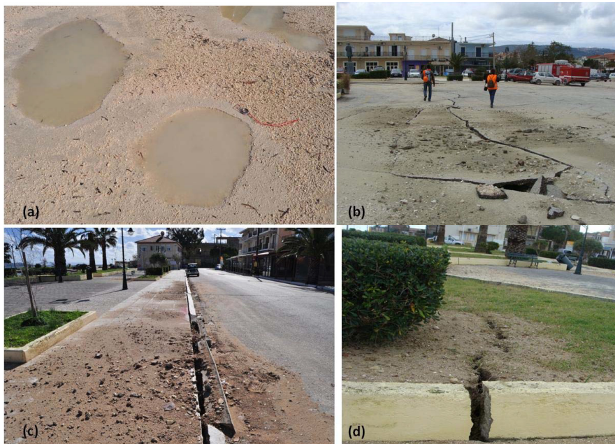
Σχήμα 2.12. Τυπικές περιπτώσεις ανάδυσης εδαφικού υλικού στο λιμάνι του Ληξουρίου (Nikolaou et al. (Eds.) 2014).
