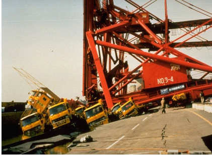
Σχήμα 2.22. Βλάβες σε γεραμούς κατά την διάρκεια του σεισμού του Hyogo-ken Nanbu (Kobe) το 1995.
