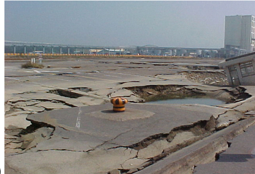
Σχήμα 2.16. (α) Παραμόρφωση του εδάφους λόγω ρευστοποίησης σε επιστροφή από άσφαλο πίσω από κρηπιδότοιχο στο λιμάνι Taichung, και (β) βλάβες στις επιστρώσεις των προκυμαίων κατά την διάρκεια του σεισμού του Chi-Chi το 1999.
