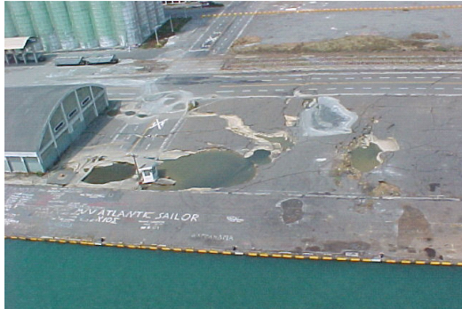
Σχήμα 2.16. (α) Παραμόρφωση του εδάφους λόγω ρευστοποίησης σε επιστροφή από άσφαλο πίσω από κρηπιδότοιχο στο λιμάνι Taichung, και (β) βλάβες στις επιστρώσεις των προκυμαίων κατά την διάρκεια του σεισμού του Chi-Chi το 1999.
