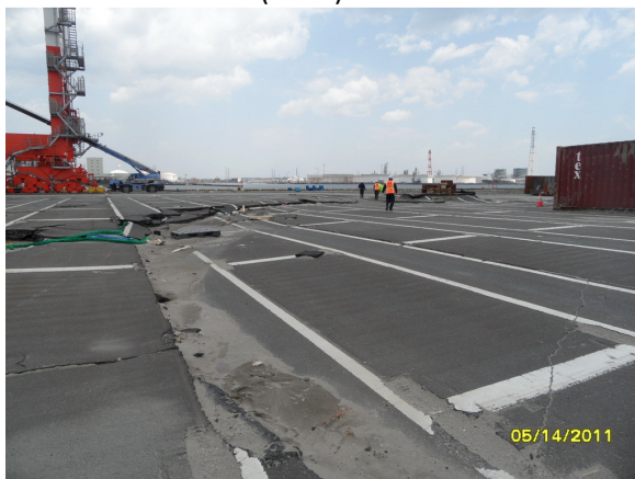
Σχήμα 2.5. Πλευρική εξάπλωση πίσω από τους κρηπιδότοιχους κατά μήκος της αρχικής ακτογραμμής κατά τη διάρκεια του σεισμού του Tohoku (Great East Japan) το 2011 (Percher 2014).
