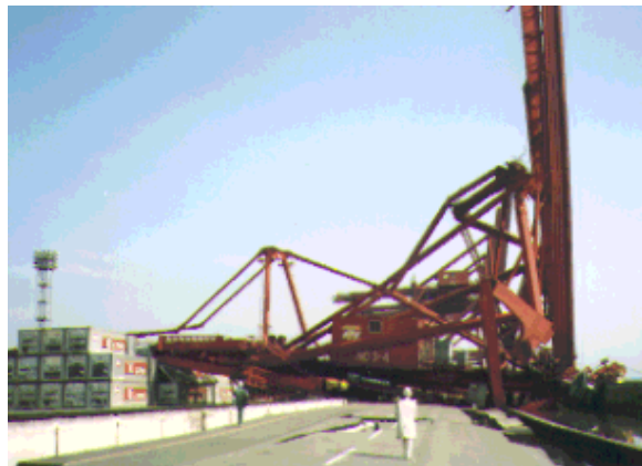
Σχήμα 2.21. Πλήρης κατάρρευση γερανού. Οι υπόλοιποι γερανοί υπέστησαν διάφορα είδη αστοχιών, όπως πλαστικές αρθρώσεις και λυγισμός των μελών τους [Σεισμός του Hyogo-ken Nanbu (Kobe) το 1995, Rokko Island].
