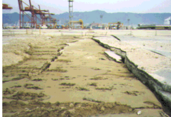
Σχήμα 2.23. Σημαντικές αποθέσεις άμμου στην επιφάνεια του οδοστρώματος κοντά σε γεραμούς των εμπορευματοκιβωτίων [Σεισμός του Hyogo-ken Nanbu (Kobe) το 1995, Port Island].
