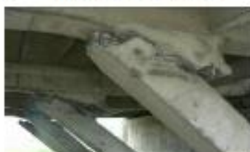
(d) damage to columns
