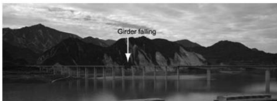
Γέφυρα Miaoziqing και το σημείο κατάρρευσης
