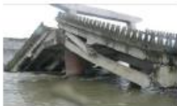
(d) damage to columns
