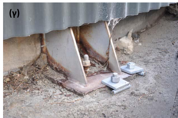
Σχήμα 7. (α) Περιοχή Fulton Hogan Bitumen Plant (GoogleEarth image, 43.6088°S, 172.7140°E). (β) δεξαμενή 2 (δεξιά, η πιο μεγάλη λευκή δεξαμενή) και δεξαμενές 3 και 4 (αριστερά, μικρότερες γκρι δεξαμενές) (γ) Επισκευή των δεξαμενών 3 και 4 (προσθήκη σφικκτήρων). Αξιοσημείωτη η αποκόλληση της αρχικής αγκύρωσης (Cubrinovski et al, 2010)
