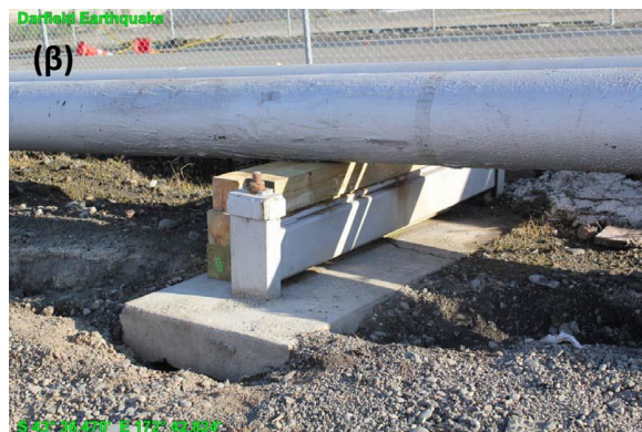
Σχήμα 2. (α) Καθίζηση και πλευρική παραμόρφωση σε αγωγό μεταφοράς καυσίμων (β) Προσωρινή ξύλινη στήριξη για παραλαβή της καθίζησης αγωγού μεταφοράς καυσίμων (Cubrinovski et al, 2010).
