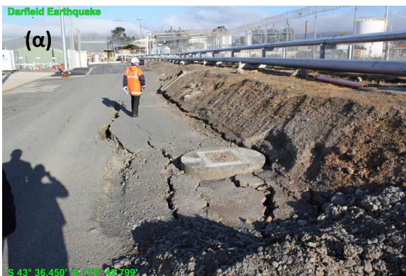
Σχήμα 2. (α) Καθίζηση και πλευρική παραμόρφωση σε αγωγό μεταφοράς καυσίμων (β) Προσωρινή ξύλινη στήριξη για παραλαβή της καθίζησης αγωγού μεταφοράς καυσίμων (Cubrinovski et al, 2010).
