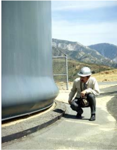
Σχήμα 30: Λυγισμός μορφής «Elephant's foot»
